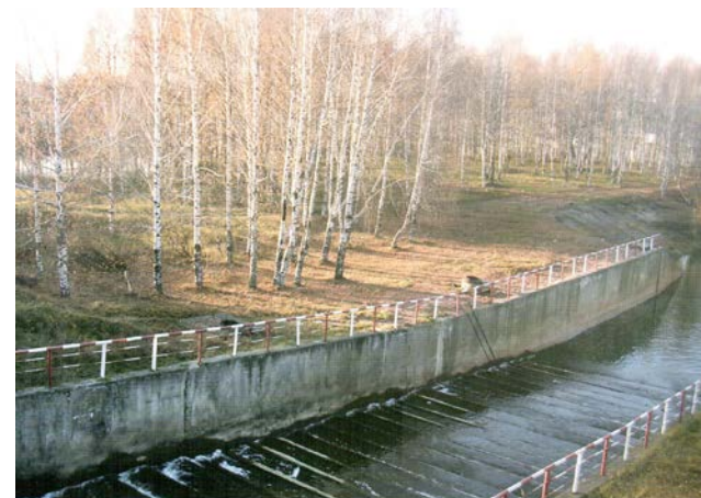
Запасный пруд. Шлюзовые сооружения
