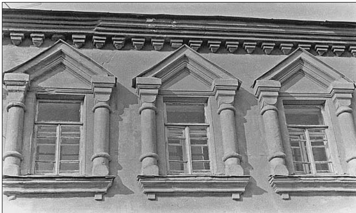
Корпус гостиницы. Наличники окон второго этажа. Фотографии 1989 года (архив НИП «Этнос»).
