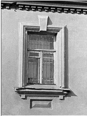
Корпус гостиницы. Наличник окна первого этажа.
