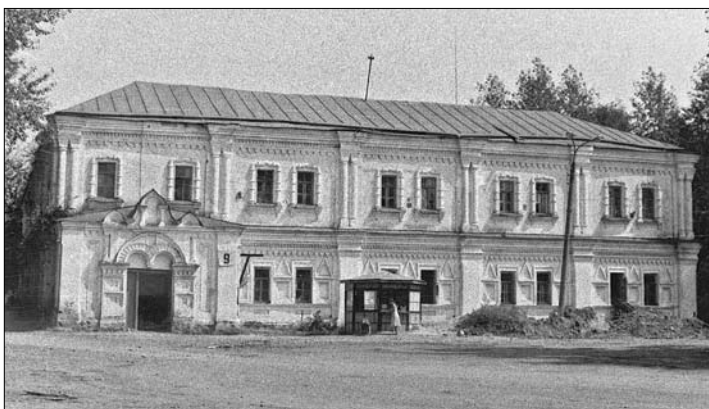
Трапезный корпус. Главный фасад. Фото 1989 г. (архив НИП «Этнос»)
