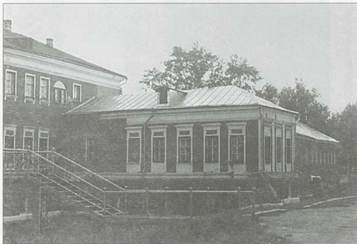
Господский дом. Вид со стороны парка.
