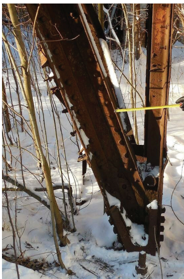
Рис. 5. Опирание арки в осях 4/А
