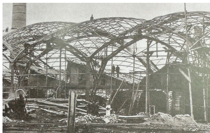
Рис. 1. Строительство листопркатного цеха («Шуховский пролёт»). 1897 год [3]
