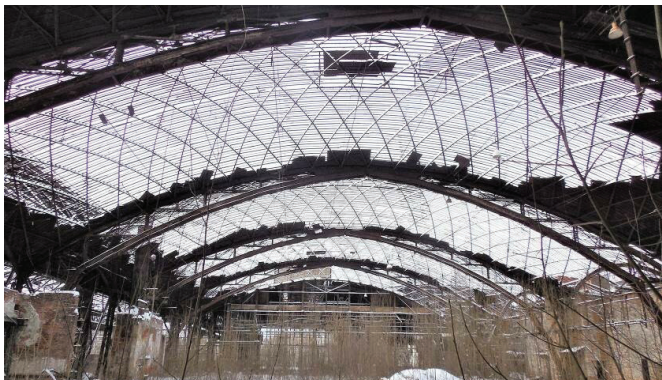
Рис. 4. Общий вид цеха в осях 1–4/А–И
